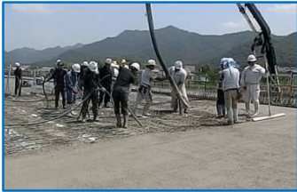
①コンクリート打設
